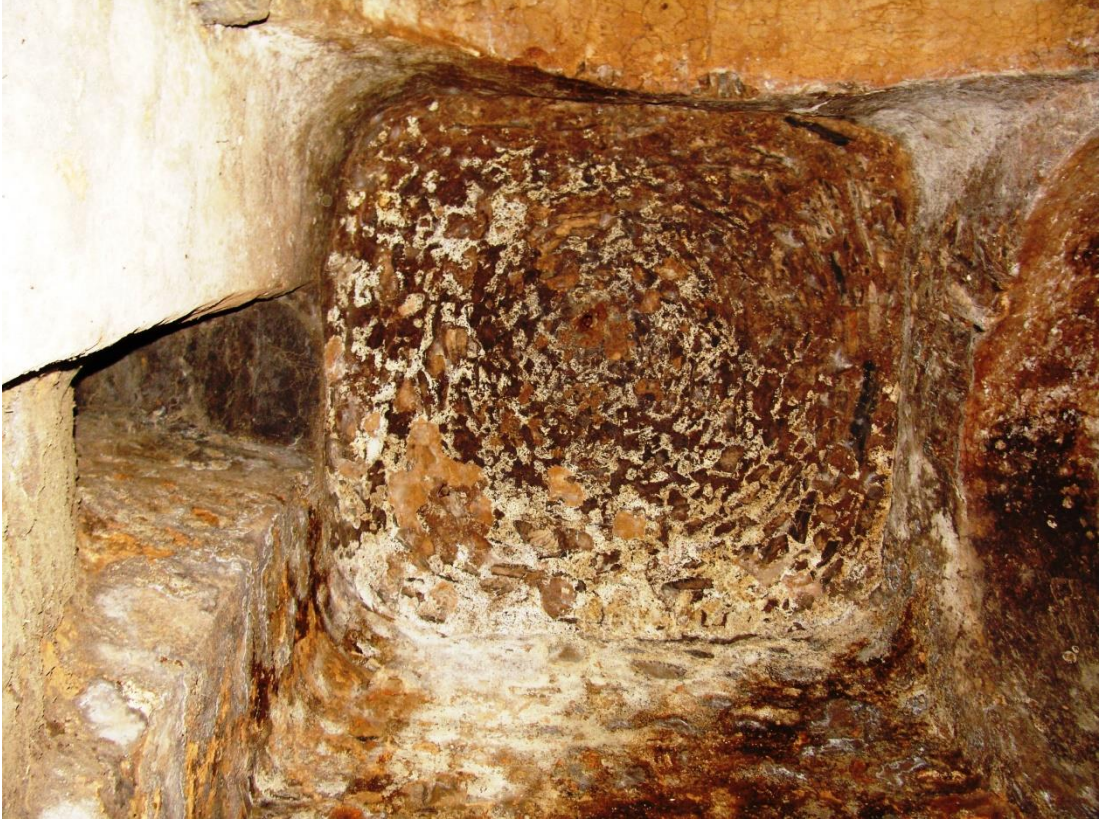
Görsel 21: Çatak Çılga (Çiçan) Kilisesi kuzeybatı köşe kubbe ve pandantif geçiş detayı
