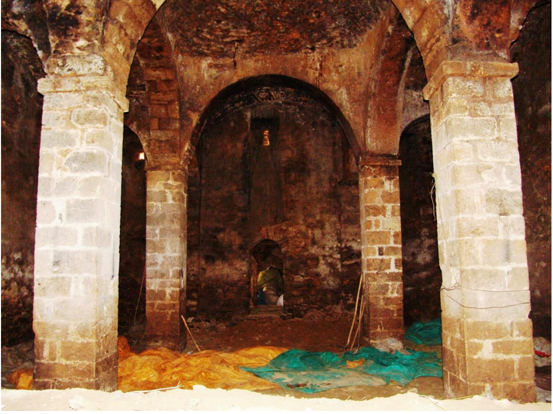
Görsel 15: Çatak Çılga (Çiçan) Kilisesi iç mekan taşıyıcı serbest payeler ve batı duvarı
