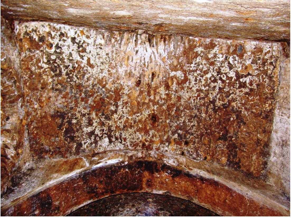
Görsel 19: Çatak Çılga (Çiçan) Kilisesi iç mekan ana yönlerdeki beşik tonoz üst örtüsü
