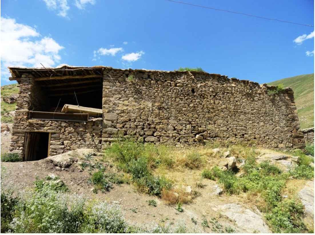
Görsel 9: Çatak Çılga (Çiçan) Kilisesi güney cephe görünüşü
