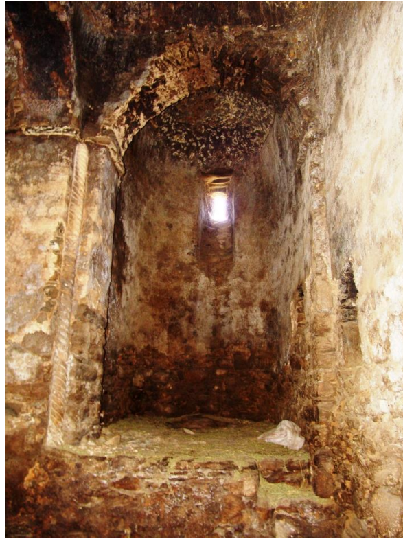
Görsel 26: Çatak Çılga (Çiçan) Kilisesi güneydoğu köşe apsidiyolün görünüşü
