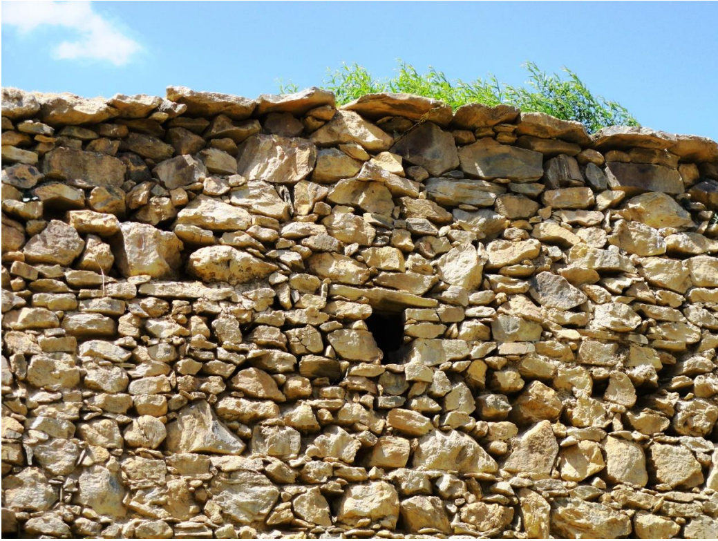
Görsel 10: Çatak Çılga (Çiçan) Kilisesi güney cephe mazgal pencere ve saçak kısmı
