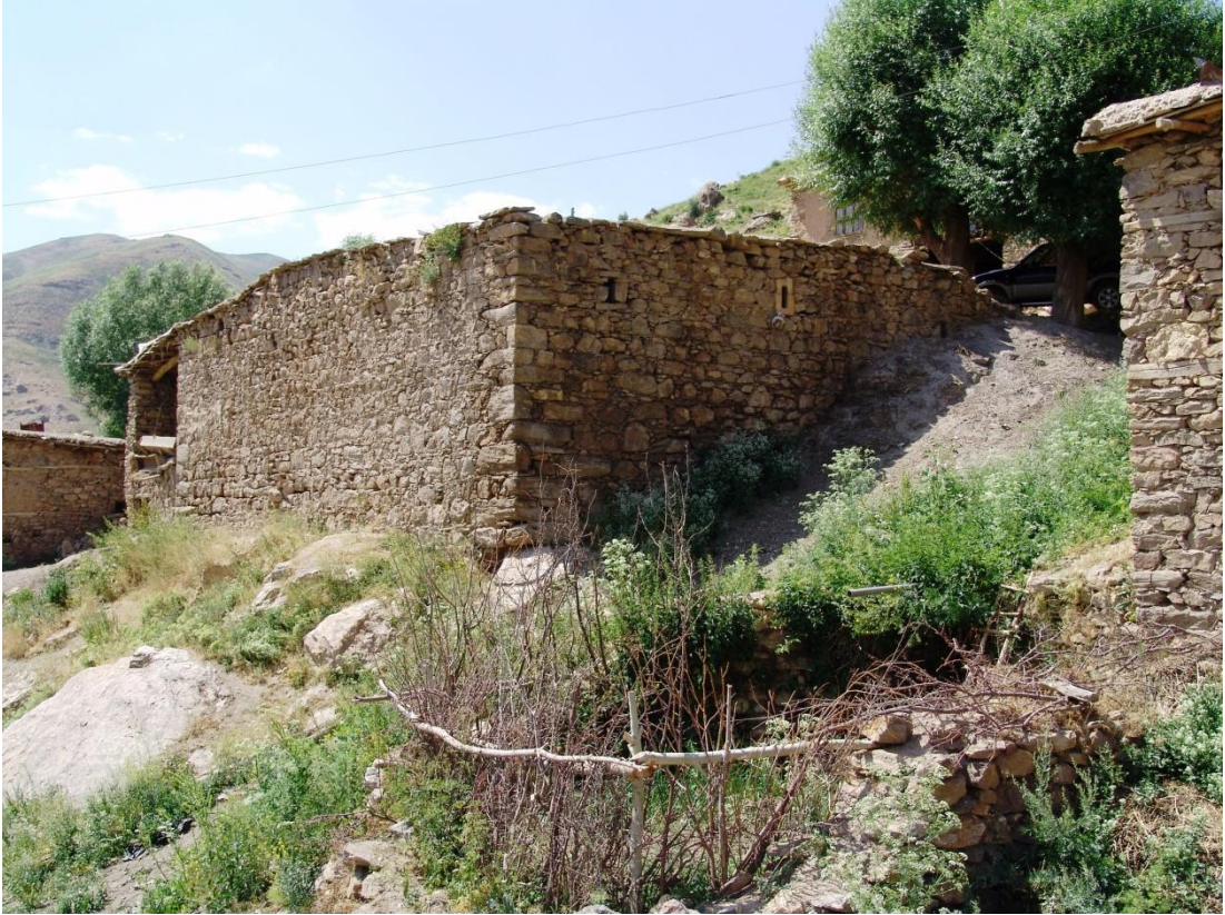
Görsel 4: Çatak Çılga (Çiçan) Kilisesi'nin güneydoğudan genel görünüşü
