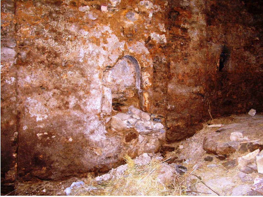
Görsel 29: Çatak Çılga (Çiçan) Kilisesi kuzeydoğu köşe duvar duvar nişinin görünüşü
