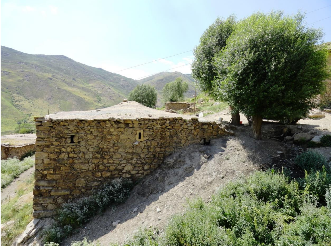
Görsel 11: Çatak Çılga (Çiçan) Kilisesi doğu cephe görünüşü
