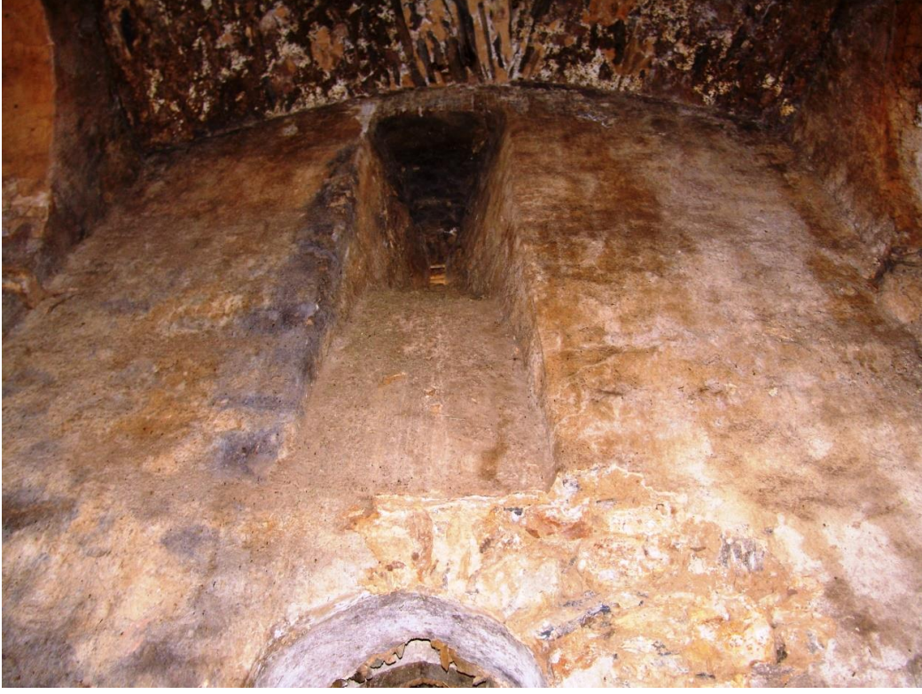
Görsel 31: Çatak Çılga (Çiçan) Kilisesi iç mekan batı girişin üstündeki mazgal pencere
