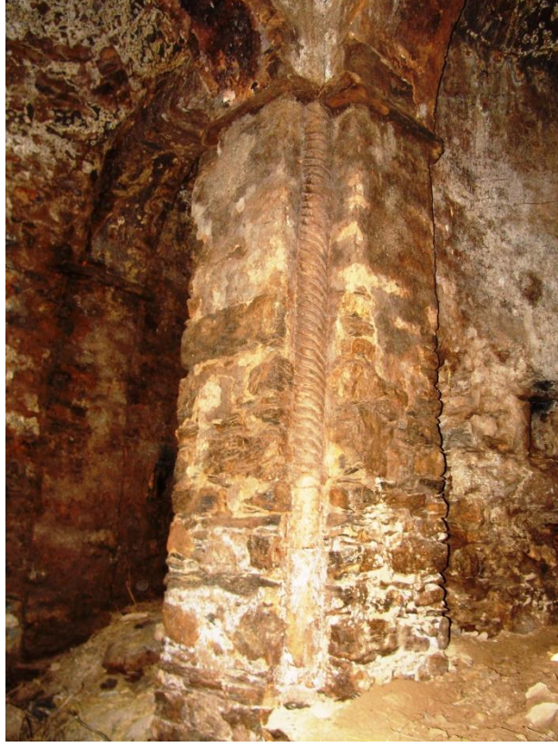
Görsel 27: Çatak Çilga (Çiçan) Kilisesi kuzeydoğu köşe duvar payesi ve yivli sütunce
