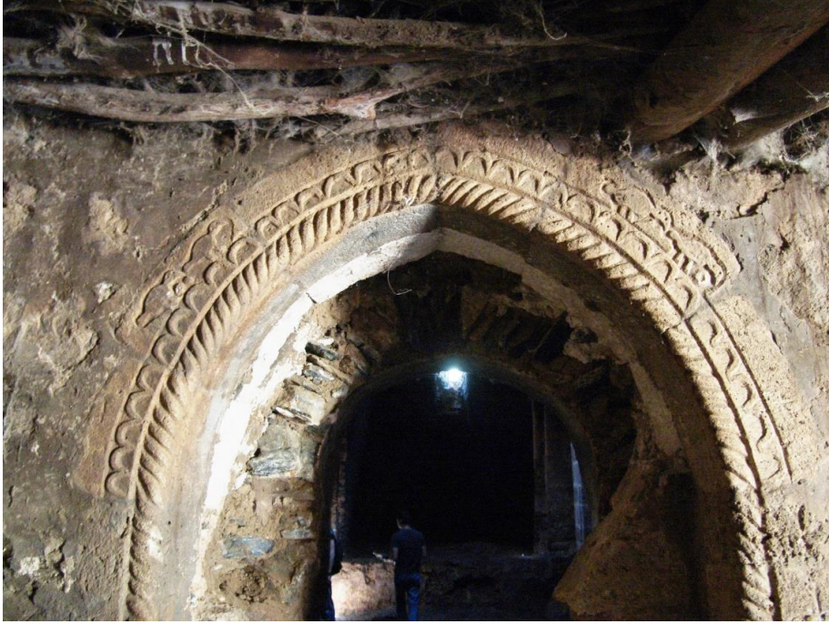
Görsel 34: Çatak Çılga (Çiçan) Kilisesi batı girişi alınlık ile yivli kaval silme ve süsleme
