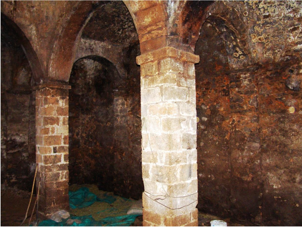
Görsel 22: Çatak Çılga (Çiçan) Kilisesi iç mekan kuzey duvarı ve payelerin görünüşü
