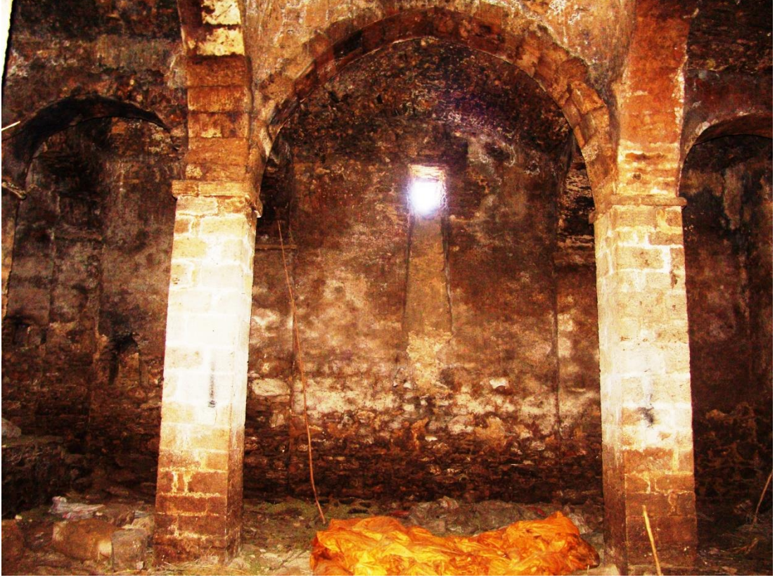
Görsel 23: Çatak Çilga (Çiçan) Kilisesi güney duvar ve mazgal pencere görünüşü
