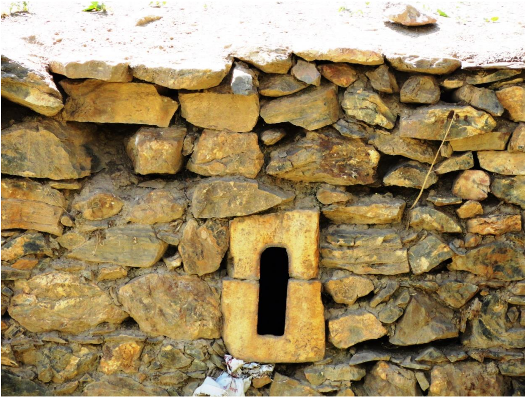
Görsel 12: Çatak Çılga (Çiçan) Kilisesi doğu cephe mazgal pencere detayı
