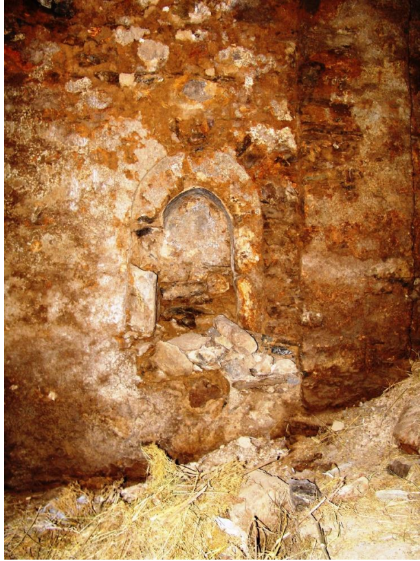
Görsel 30: Çatak Çılga (Çiçan) Kilisesi güneydoğu köşe duvar nişinin görünüşü
